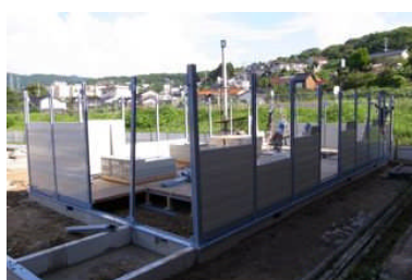
仮設校舎立ち上げ
